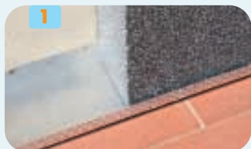
1 Posizionamento profilo di partenza
