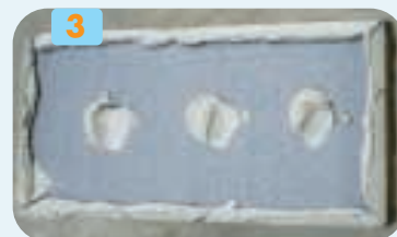
3 Corretta disposizione del collante
